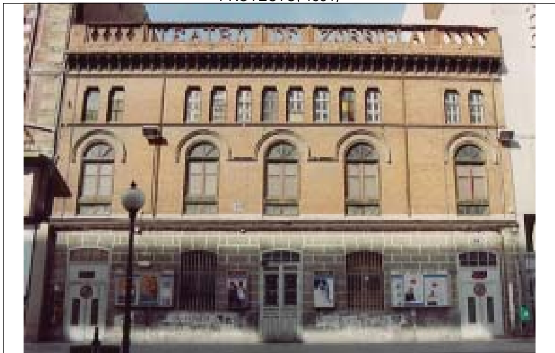
FACHADA POSTERIOR DEL TEATRO DE ZORRILLA CON EL LETRERO EJECUTADO CON LADRILLOS PRENSADOS COLOCADOS A TIZÓN (AÑO DEL PROYECTO, 1884)
