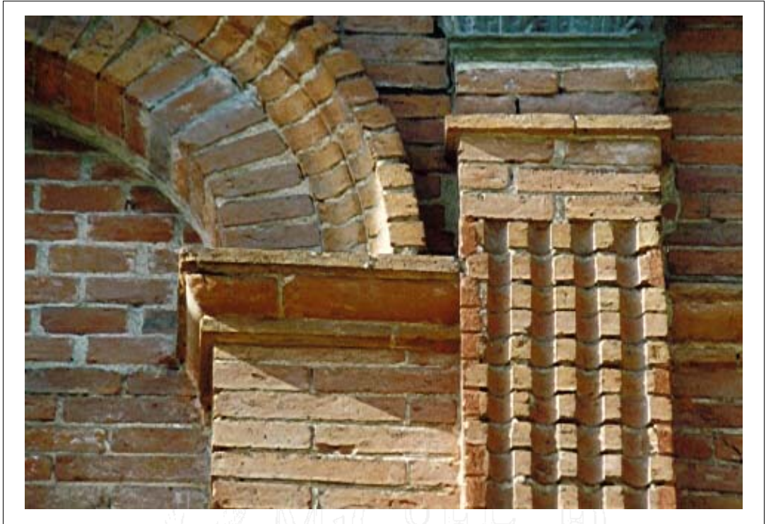
LADRILLOS APLANTILLADOS DE LA CASA DEL ESTUDIANTE
