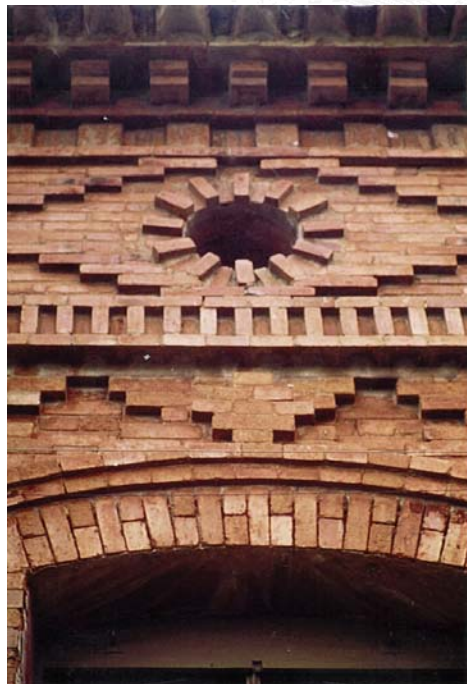
ÓCULO Y CORNISAS RESALTADAS EN EL MISMO PLANO DE UN EDIFICIO DE VIVIENDAS (VALLADOLID)
