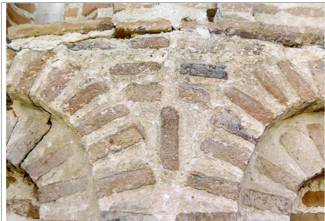
ENJUTA DE LOS ARQUILLOS CIEGOS DEL ÁBSIDE DE LA IGLESIA DE SAN MIGUEL ARCANGEL DE ALDEA DE SAN MIGUEL, VALLADOLID.
