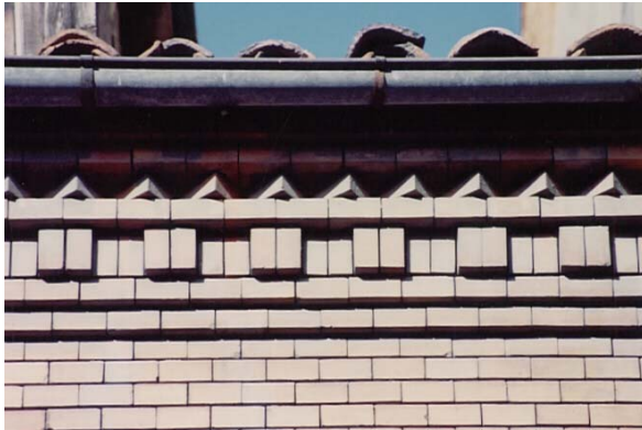
ALERO FORMADO POR UNA HILADA DENTADA DE RITMO 2/2 QUE CONFIGURA EL MOTIVO DE CANES MAS SIMPLE, DE UN EDIFICIO DE VIVIENDAS DE LA CALLE SAN LUIS (VALLADOLID)
