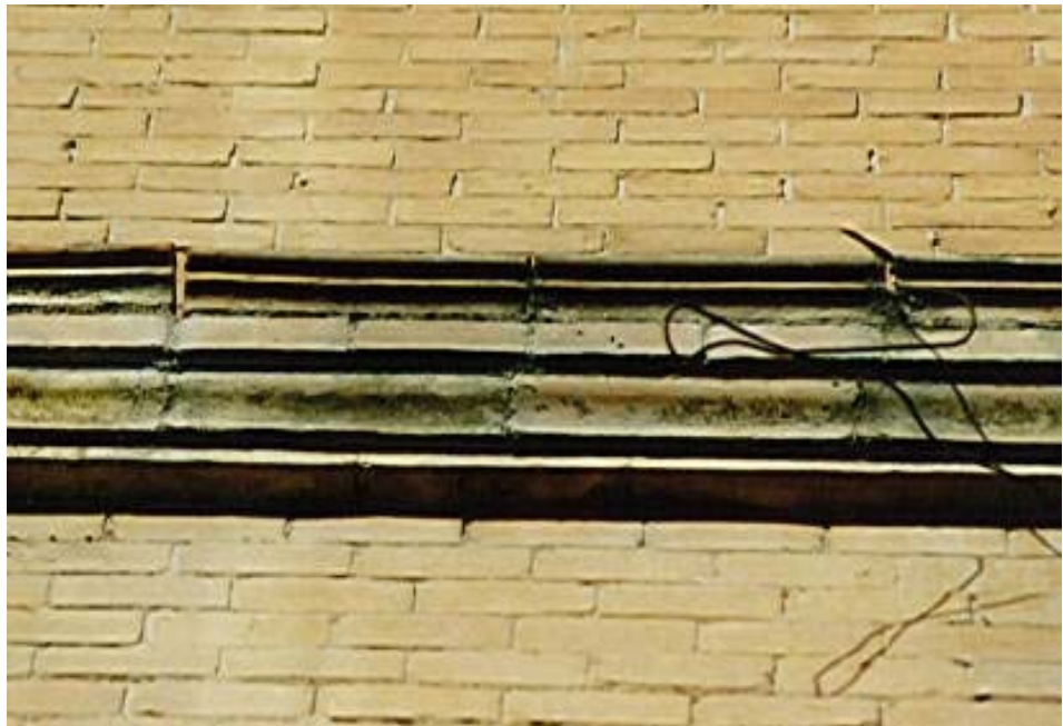
LADRILLOS APLANTILLADOS CON LA MOLDURA CORRIDA EN LA TESTA DE LA CORNISA DE CINCHA DE UN EDIFICIO DE VIVIENDAS DE LA PLAZA DE LA RINCONADA, VALLADOLID.
