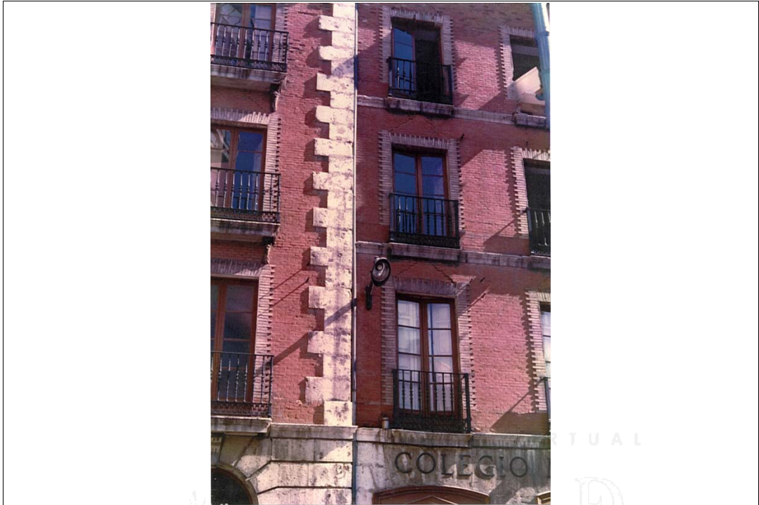
COLEGIO MAYOR REYES CATÓLICOS, ANTES DE SU RESTAURACIÓN, EL PROYECTO ES DEL AÑO 1988. LAS CORNISAS, PILASTRAS Y FACHADA DE PLANTA BAJA SON DE PIEDRA
