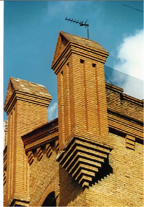
TORREONES DEL EDIFICIO DE LA ELECTRA (VALLADOLID)
