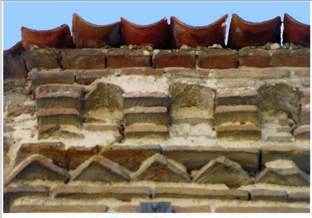
ALERO DE LA NAVE DE LA IGLESIA DE SAN JUAN DE OLMEDO, VALLADOLID: Hcv - Hcv - M3 - Hcv - Htv - Hcv
