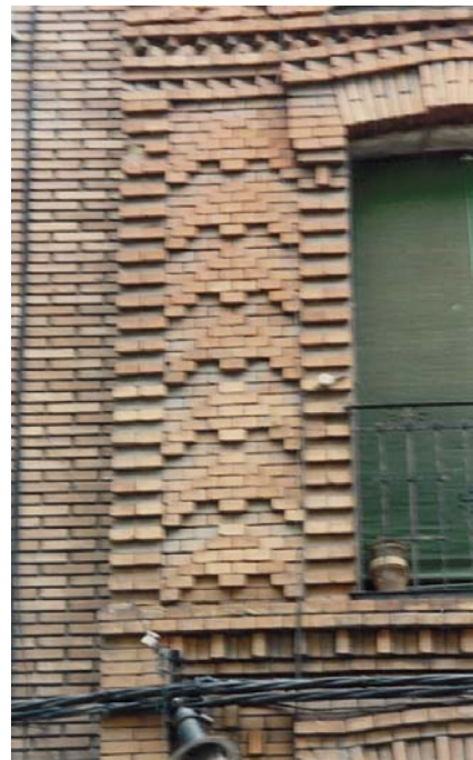
MOTIVOS EN FORMA DE FLECHA Y TRASDÓS DE ARCO DE CIERRE DE HUECO, CURVO, EN UN EDIFICIO DE LA CALLE MANTERÍA (VALLADOLID)
