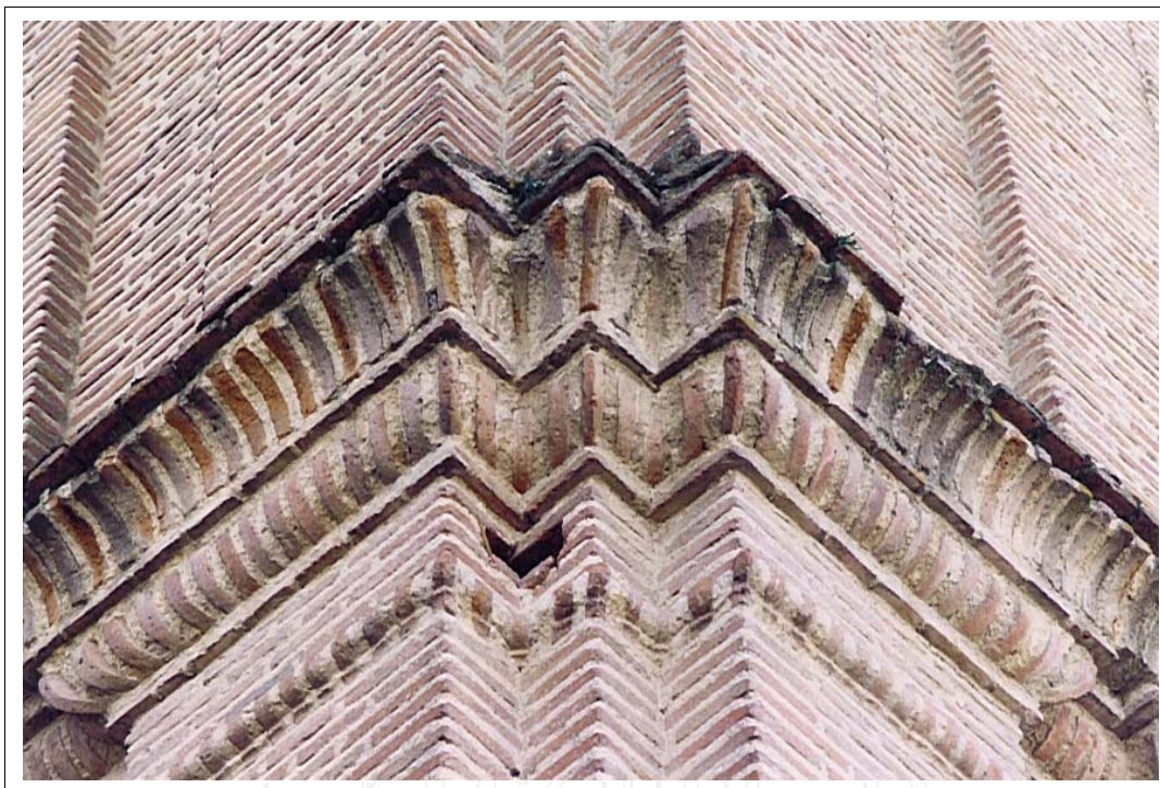
CORNISA DE LA TORRE DE LA IGLESIA DE SANTA MARÍA DE MATAPOZUELOS: Hcv - Scvlm - Hcv - Scvlm - Hcv
