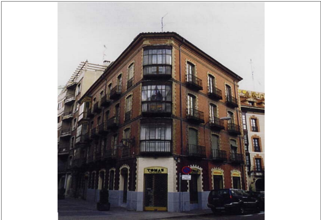
EDIFICIO CON LA FACHADA CON LA ORNAMENTACIÓN EN CORNISAS, BORDES LATERALES Y HUECOS, EJECUTADA CON LADRILLOS AMARILLOS
