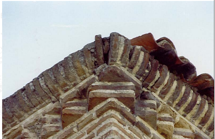
ALERO DE LA TORRE, SIGUIENDO EL TRAZADO CURVO DEL ENCUENTRO DE LAS DOS FACHADAS Y EL APILASTRADO, DE LA IGLESIA DE SANTIAGO DE ALCARARÉN, VALLADOLID.
