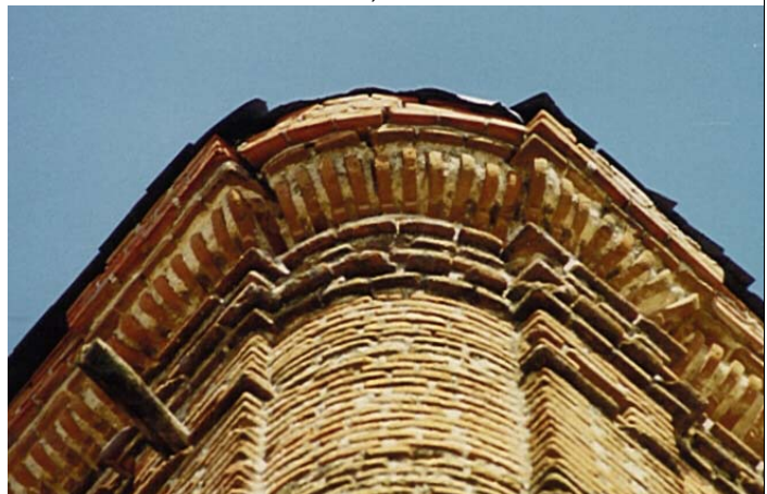
ALERO DE LA TORRE, SIGUIENDO EL TRAZADO CURVO DEL ENCUENTRO DE LAS DOS FACHADAS Y EL APILASTRADO, DE LA IGLESIA DE SANTIAGO DE ALCARARÉN, VALLADOLID.
