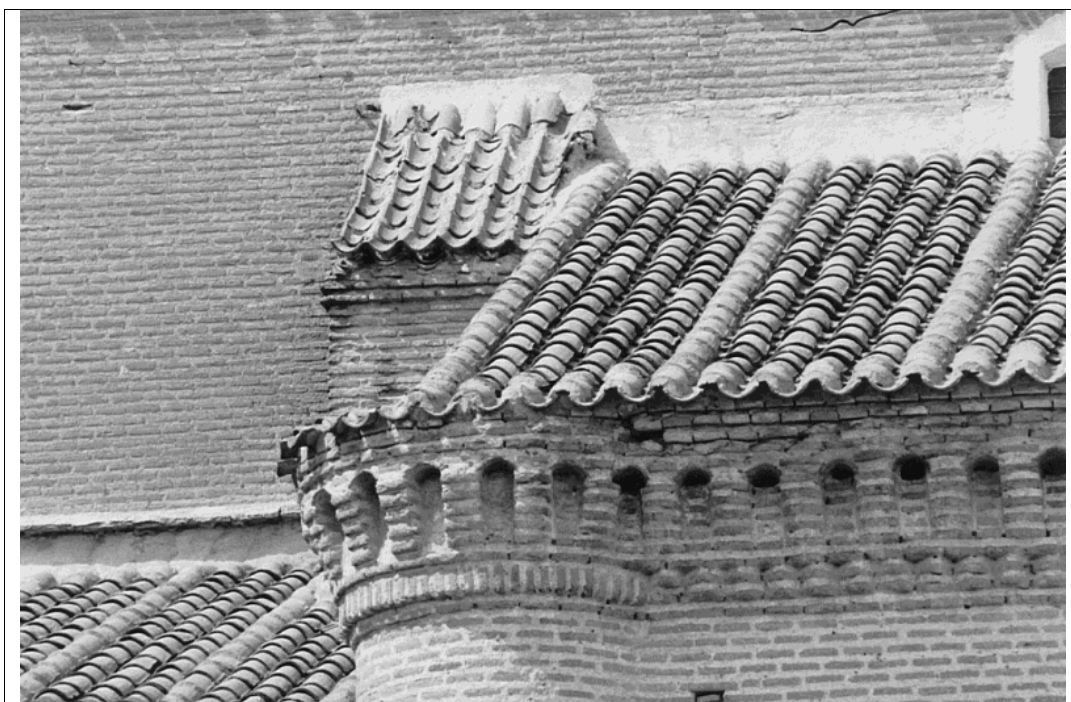
ALERO DE LA IGLESIA DE LA ASUNCIÓN DE LA SECA, VALLADOLID: muro curvo: Hcv - Hcv - Hcv - M5 - Hcv - Scv - Hcv muro recto: Hcv - Hcv - Hcv - M5 - Hcv - 2HTv - Hcv
