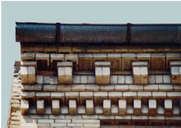
ALERO DE CANECILLOS FORMADO POR SARDINEL DENTADO DE RITMO 2/3 Y REMATADA POR UNA HILADA DENTADA CON EL MISMO RITMO DEL SARDINEL, DEL COLEGIO COMPAÑÍA DE MARÍA (VALLADOLID)
