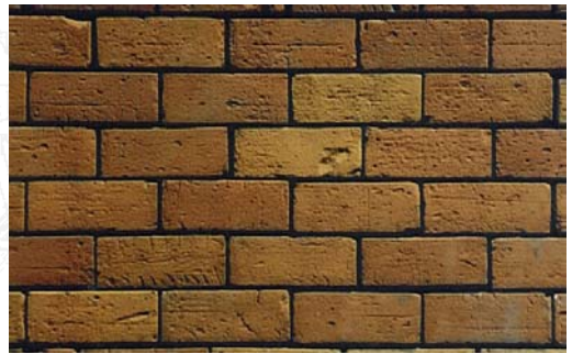
EDIFICIO DE LA ESTACIÓN ladrillo prensado 25 x 12,5 x 4,7cm
