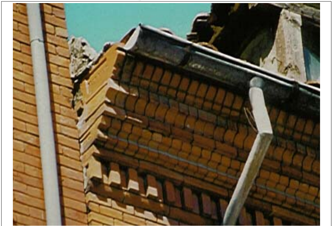
LADRILLOS APLANTILLADOS DE UN EDIFICIO DE VIVIENDAS
