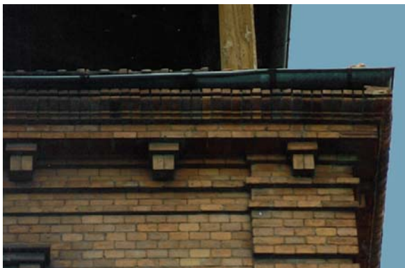
ALERO FORMADO POR DOS LADRILLOS A SARDINEL MAS SEPARADOS QUE LOS ANTERIORES Y REMATADOS SUPERIORMENTE SARDINEL CORRIDO DE LADRILLOS MOLDURADOS DE UN EDIFICIO DEL PASEO DE FILIPINOS (VALLADOLID)
