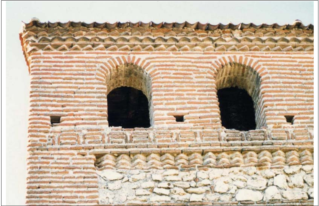
ORNAMENTACIÓN CON LADRILLOS COLOCADOS A SARDINEL ENTRE LADRILLOS SUPERPUESTOS. IGLESIA DE SAN JUAN DE MOJADOS, VALLADOLID.
