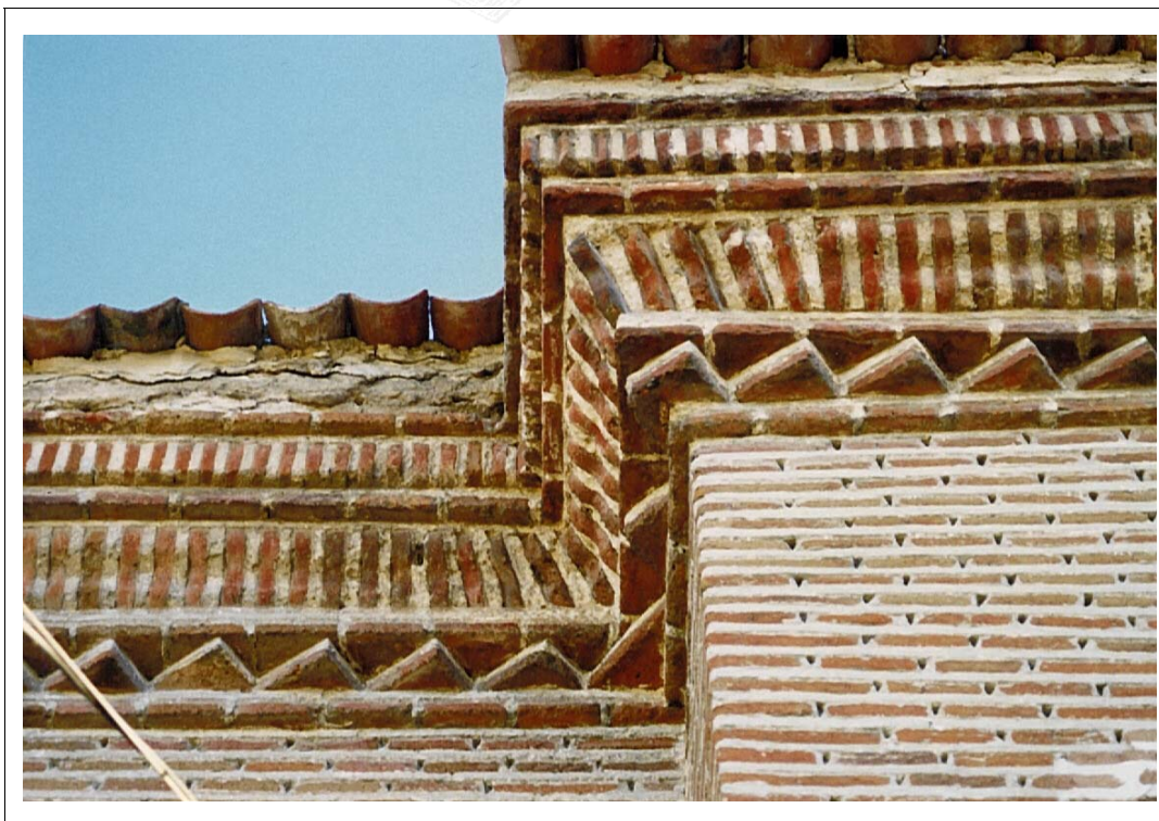
CORNISA DE LA IGLESIA DE SANTIAGO DE ALCAZARÉN, VALLADOLID: Hcv - Scv - Hcv - Scvlm - Hcv - Htv - Hcv
