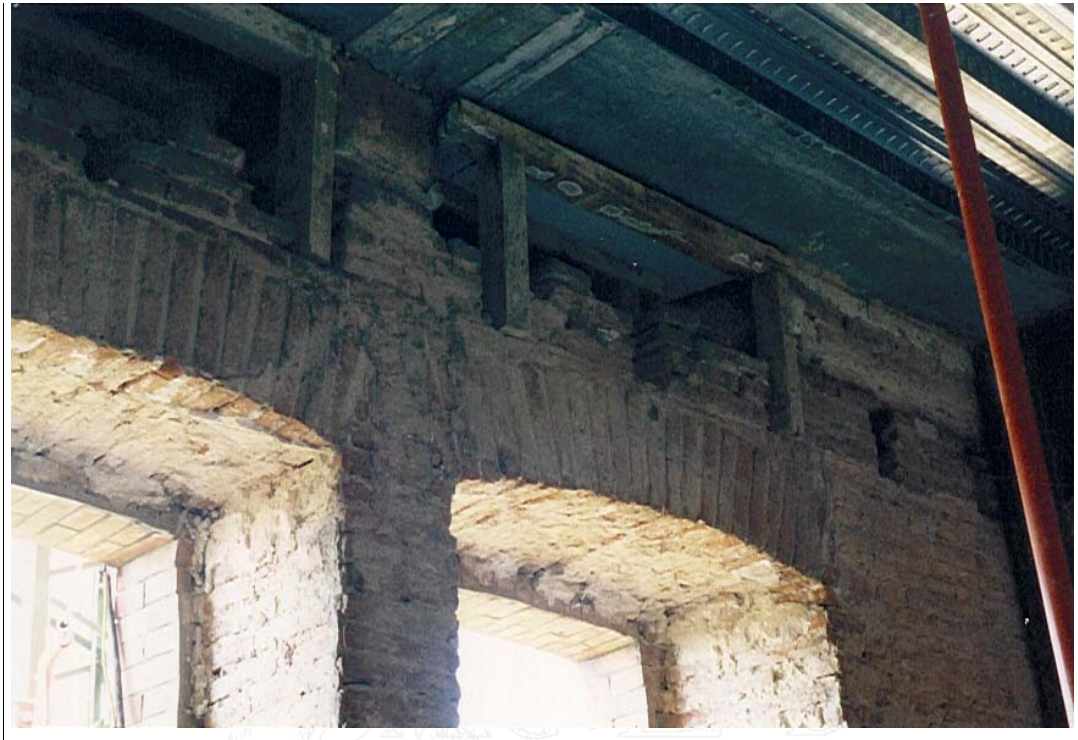
INTERIOR DE LA FACHADA DEL PALERO CON LADRILLO ORDINARIO CON APAREJO DE TIZONES (DE 1 2 ASTA CON LADRILLOS DE 28x14cm) . SE PUEDE VER LA MOCHETA Y 1 ASTA DE LADRILLO PRENSADO AL EXTERIOR.
