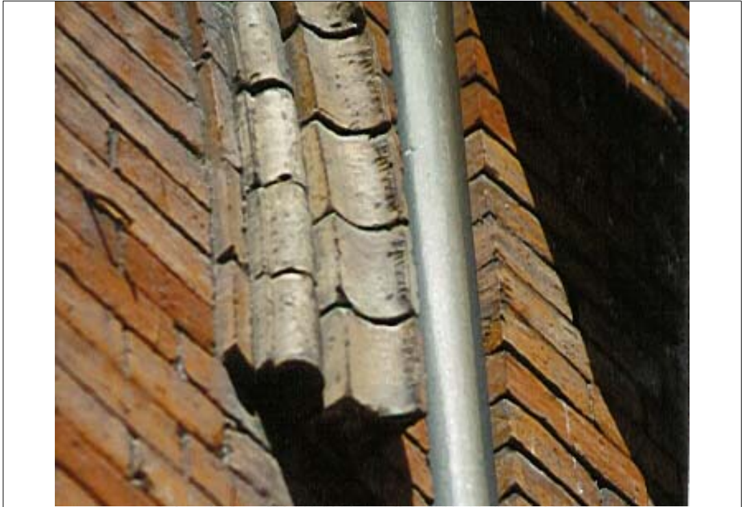
DETALLE DE LOS LADRILLOS QUE FORMAN EL ARCO DE UN HUECO DEL TEATRO ZORRILLA, VALLADOLID.
