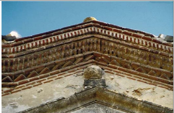
CORNISA DEL FRONTÓN DE REMATE DE LA PORTADA CON HILADAS INCLINADAS Y LADRILLOS A SARDINEL, ESCALONADOS, DE LA IGLESIA DE SANTIAGO DE ALCAZARÉN, VALLADOLID.
