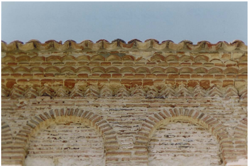
ALERO DE LA NAVE DE LA IGLESIA DE ALDEA DE SAN MIGUEL, DE VALLADOLID: filas de bocatejas entre hiladas voladas
