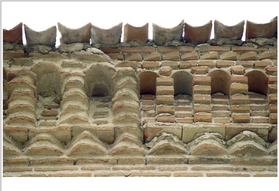
ALERO DE LA NAVE DE LA IGLESIA DE BOBADILLA DEL CAMPO, VALLADOLID: Hcv - M5 - Hcv - 2Htv - Hcv
