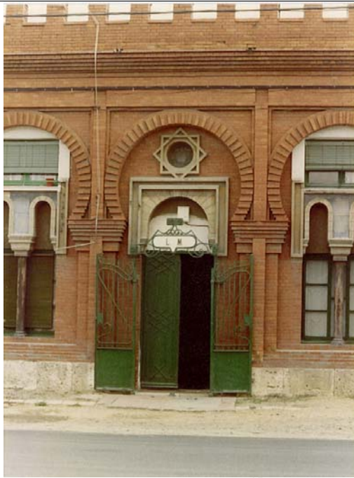
ARCOS DE HERRADURA, APAREJADOS Y DENTADOS DE UN EDIFICIO DEL CAMINO VIEJO DE SIMANCAS (VALLADOLID)
