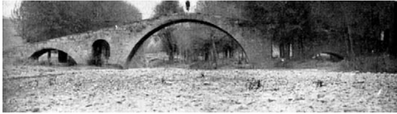
Fig. 1.- Puente romano sobre el río Navarre, entre Luco y Calamocha.
