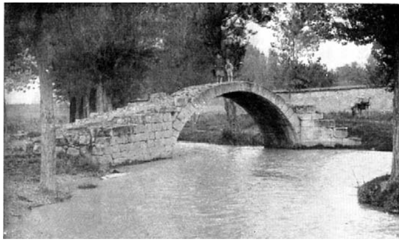
Fig. 2.- Puente romano de Calamocha (Teruel) sobre el río Jiloca. Vista general.
