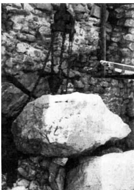
Acoplamiento de uno de los enormes sillares del muelle.
