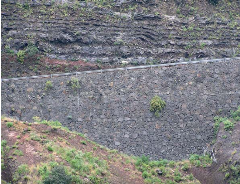
Muro de contención de piedra natural perfectamente integrado en el paisaje, que posibilita el asentamiento de vegetación y pequeños animales en las grietas
