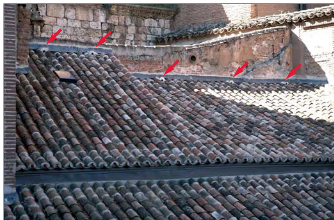
En los caballetes de los tejados interiores se diseñaron y realizaron nidos para el cernícalo primilla
