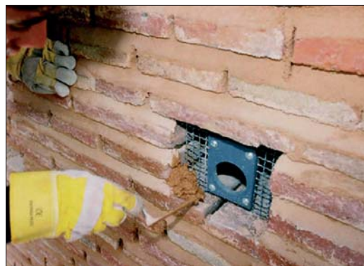
Recibiendo con argamasa la estructura colocada en el mechinal
