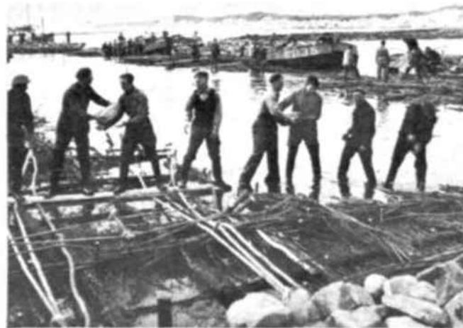
Los diques, empresa de gigantes y trabajo de hormigas.
