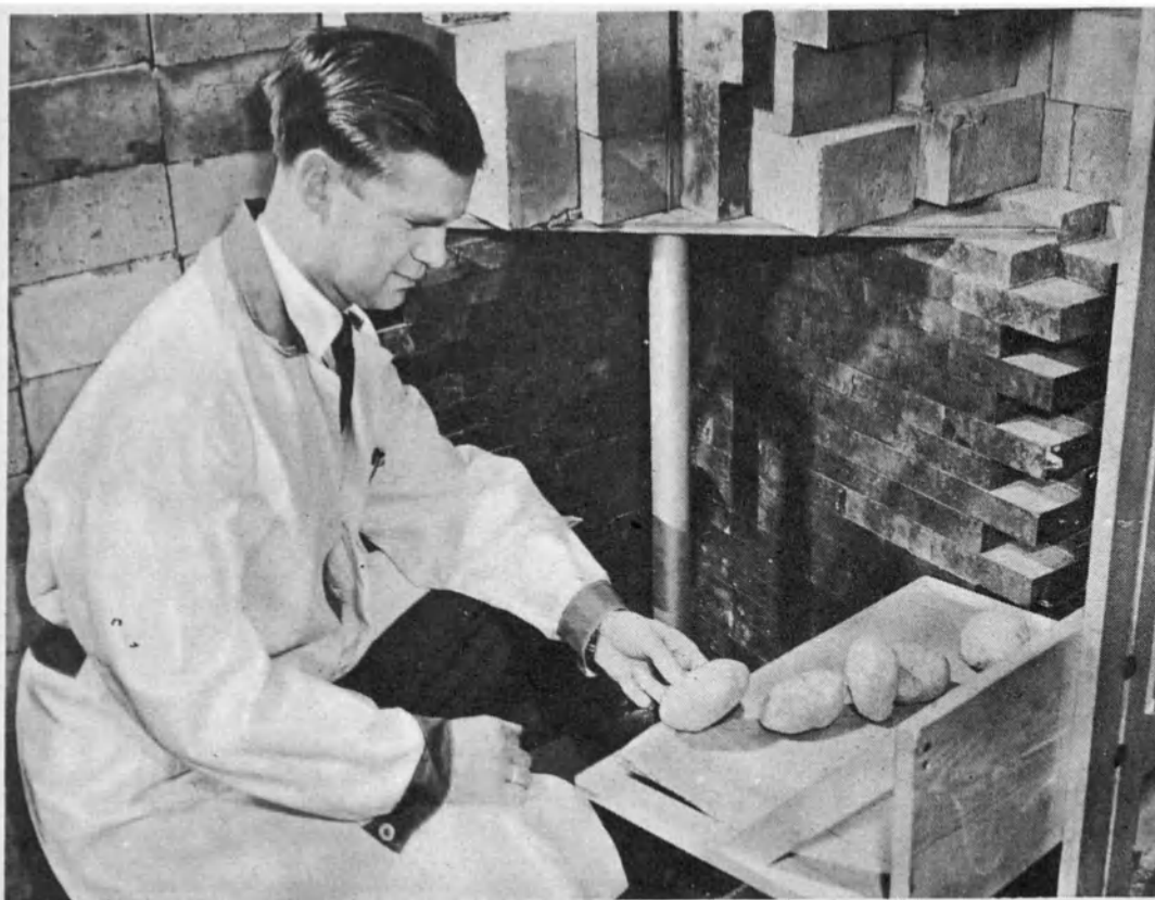
LA CONSERVACION DE LAS PATATAS por el procedimiento de exponerlas a los rayos gamma formó parte de un experimento realizado en el Laboratorio Nacional de Brookhaven para observar los efectos de la radiación sobre las plantas. Los tubérculos no germinados, sujetos a la radiación, permanecieron en perfecto estado durante meses bajo tierra donde normalmente debieron podrirse. Otro experimento demostró que los organismos vivos toleran mejor una exposición completa a los rayos, cuando la radiación se efectúa en un período prolongado y no se concentra en un tiempo breve que puede causar graves daños.
