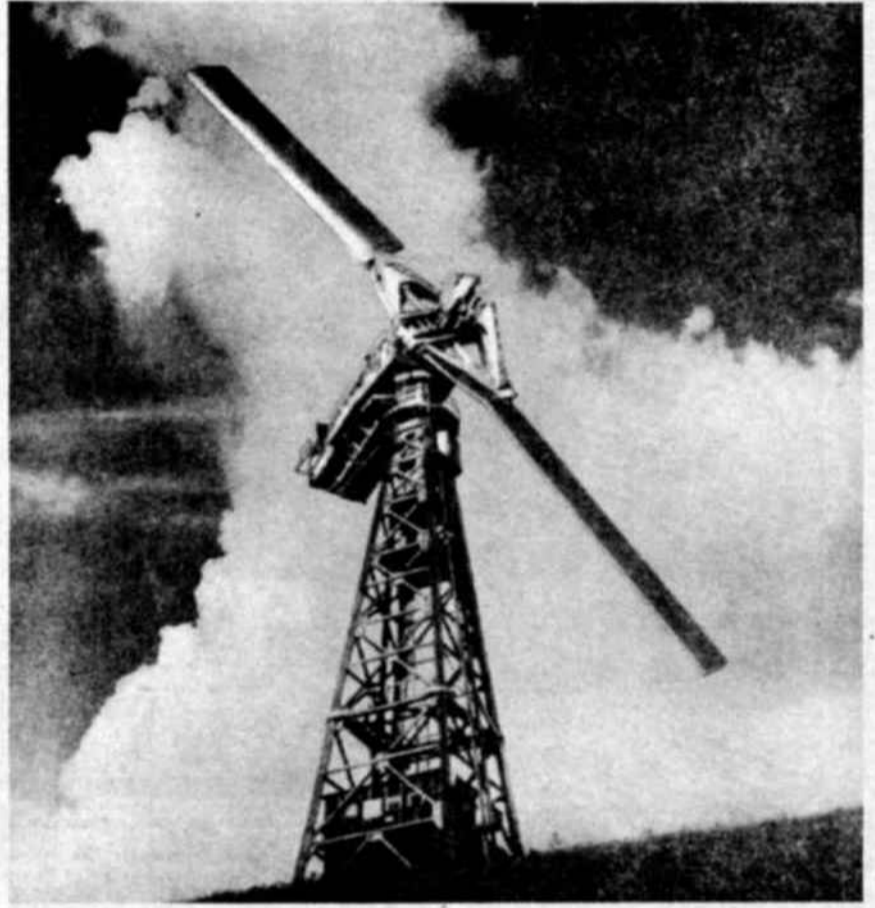
El mayor generador eólico construido hasta la fecha es el que podemos ver en esta fotografía, erigido en Vermont Hill, Estados Unidos. Su hélice alcanza un diámetro de 53 metros.
