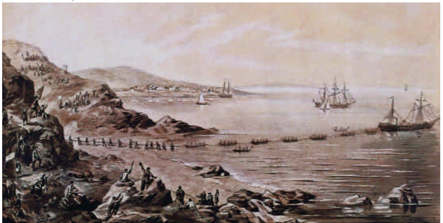
Instalación de un cable telegráfico submarino desde la isla de Valencia, en el oeste de Irlanda. Grabado de 1857.
