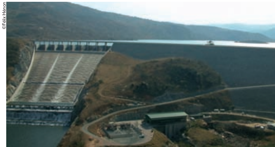
Una presa en Swazilandia.
