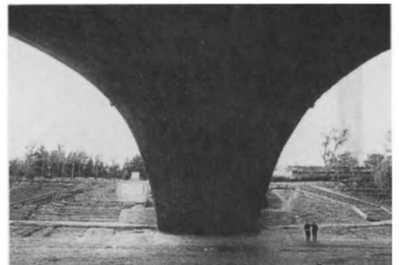
podían pasar por ellas reduciendo la posibilidad de que los soportes del puente principal se desmoronaran como consecuencia de una avenida repentina, se disminuía además el peso total del puente, con lo cual disminuía la tendencia de éste a combarse al hundirse los extremos en las orillas del río, y se ahorraba una enorme cantidad de materiales que normalmente tendrían que haberse empleado en la construcción de los extremos sólidos del puente.
