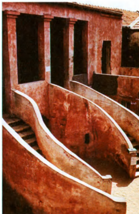
La Casa de los Esclavos antes de ser restaurada.
