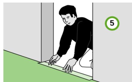
**5** Fijar el perfil de unión en el umbral de la puerta.
