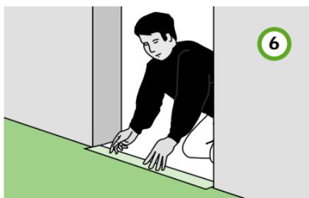
**6** Fijar los perfiles de unión en el umbral de las puertas. Esperar 24 h antes de colocar muebles pesados en la habitación.
