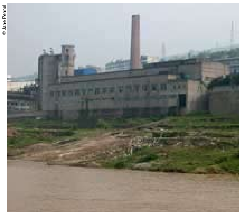
Una de las fábricas que contaminan las aguas del Río Yangtsé.
