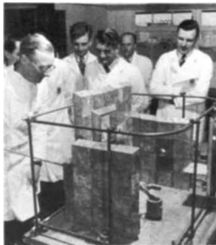
EN EL CENTRO DE INVESTIGACION ATOMICA DE HARWELL (Reino Unido) un muro de ladrillo protege a los operarios contra las radiaciones nocivas desprendidas en el curso de las manipulaciones de elementos químicos radioactivos. Para colocar objetos en el crisol de isótopos (a la derecha), o para retirarlos, la prudencia ha impuesto el uso de largas pinzas.
