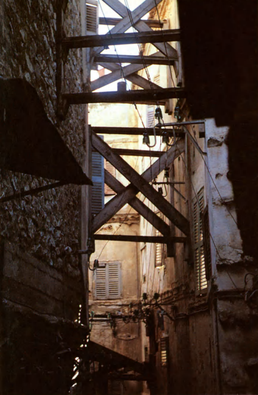
Estructuras para sostener los muros de un edificio en peligro, Argel.
