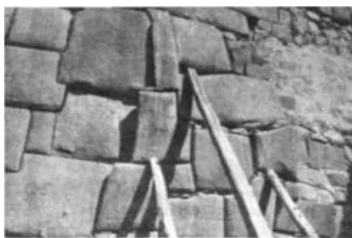
He aquí como ha quedado la muralla incaica de tipo ciclópeo de la calle Atun-Rumico de El Cuzco, después del sismo que azotó la ciudad el 21 de Mayo. Las grandes losas pétreas que habían resistido el decurso de los siglos y numerosos temblores de tierra, se desprendieron de sus sujeciones de argamasa, cayeron al suelo y fué necesario numerarlas para rehacer el revestimiento. En la foto se aprecia bien la clase de trabajo que los arquitectos peruanos precolombinos realizaron a fin de defender de la ciudad imperial.
