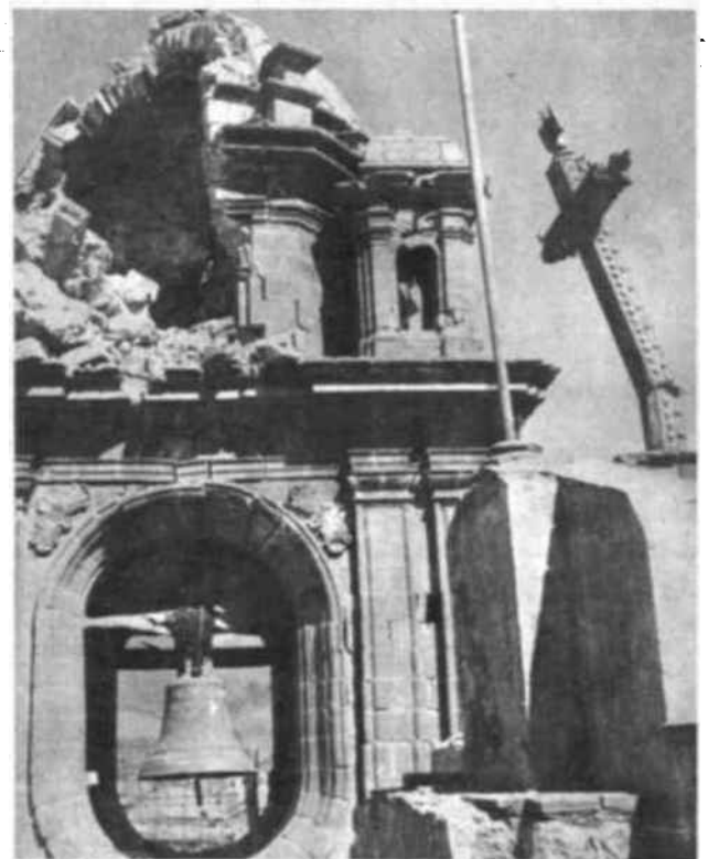
La Iglesia de la Compañía (construida por los Padres Jesuitas), como la de la Merced, la de San Sebastián la Catedral y otras, sufrieron los embates del temblor, y a pesar de la gran solidez de su construcción, que puede apreciarse bien en esta foto, donde vemos la torre derecha de la primera de las mencionadas Iglesias (la de la Compañía), cuya parte superior izquierda queda demolida y cuarteado gravemente todo el resto del edificio. En la parte derecha de la foto aparece el estado en que quedó la gran cruz de piedra labrada de la fachada principal de la iglesia.
