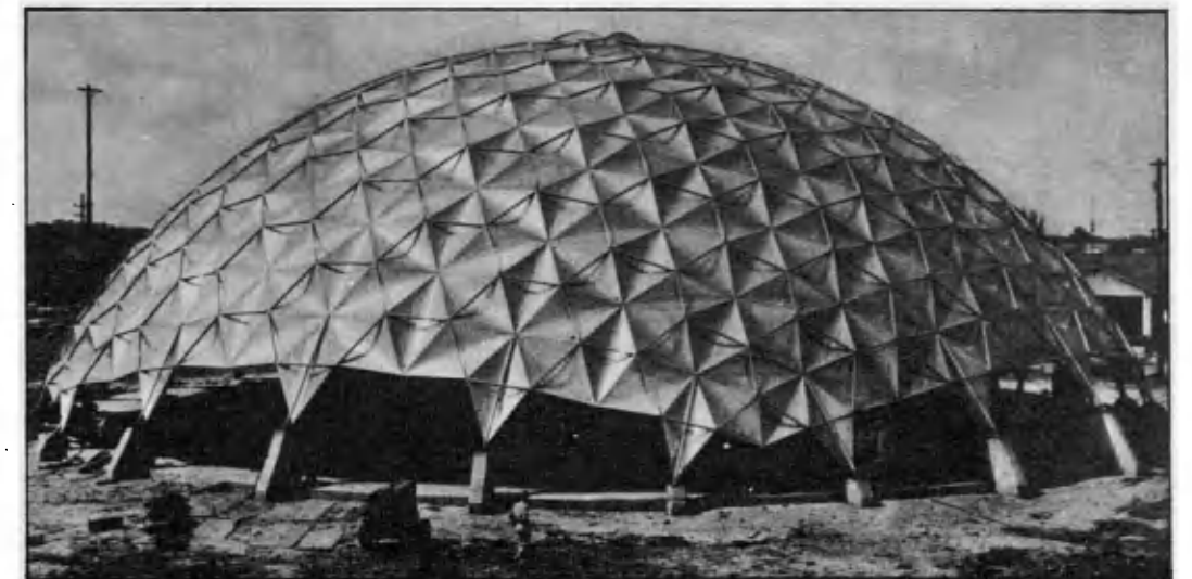
El hombre se adapta difícilmente a las nuevas formas impuestas por la técnica moderna. Así, este "caparazón de tortuga" (foto de la derecha) es el domo geodésico que se ha construido en Baton Rouge, Luisiana, y que muestra el ensamblamiento de los paneles de aluminio que lo componen. Esos paneles son de doce formas y gálibos diferentes. El domo no tiene soportes internos y es una de las construcciones circulares más grandes del mundo en su género. Sirve de taller de reparaciones de los vagones-cisternas. La foto superior —tomada durante la construcción del domo— muestra la forma en que las 420 secciones fueron izadas a la altura conveniente por medio de grúas, sostenidas luego por mástiles y soldadas a partir de la cúspide. La foto de la izquierda representa a un técnico en el momento de efectuar ensayos de sonoridad sobre un gran transformador en la sala de investigaciones acústicas. Los muros de la sala tienen más de un metro y medio de espesor y están contruidos con diversos materiales: cemento, una capa de hojas de hierro galvanizado y de fibras de vidrio.
