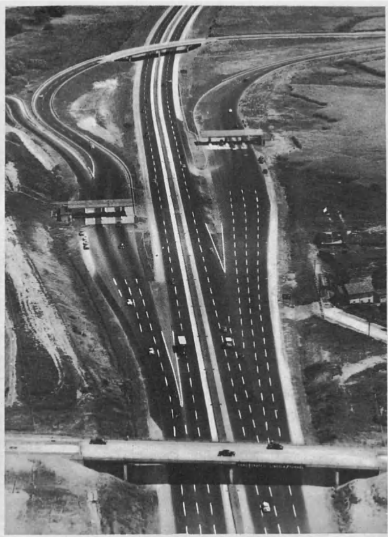
SE PAGA AL PASAR. Puesto de portazgo (parte superior de la foto) en la autopista de Nueva Jersey (centro). El tráfico principal se efectúa por la vía central. Las vías laterales (izquierda y derecha) comunican con el Túnel de Lincoln que pasa bajo el río Hudson y conduce a Nueva York.
