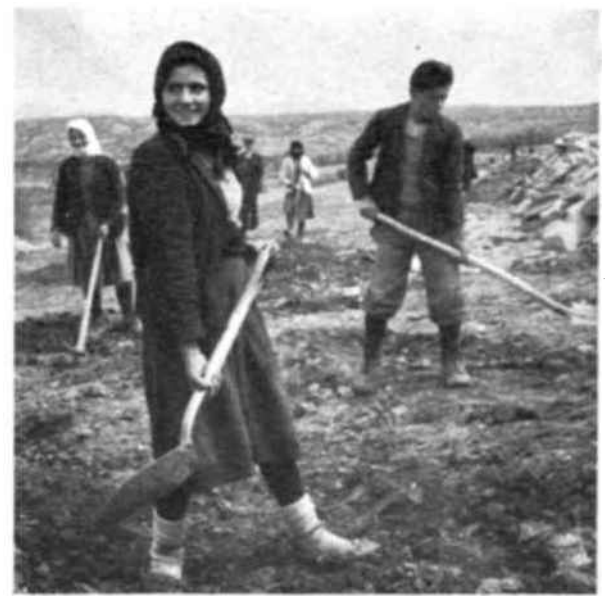
Construcción de nuevas carreteras en Grecia.
