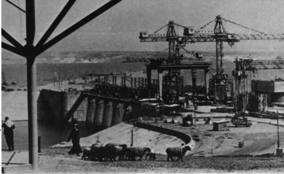
Esta presa construida en el Eufrates (Irak) permitirá regar muchas hectáreas de nuevas tierras, además de producir la electricidad indispensable para la industrialización del país.
