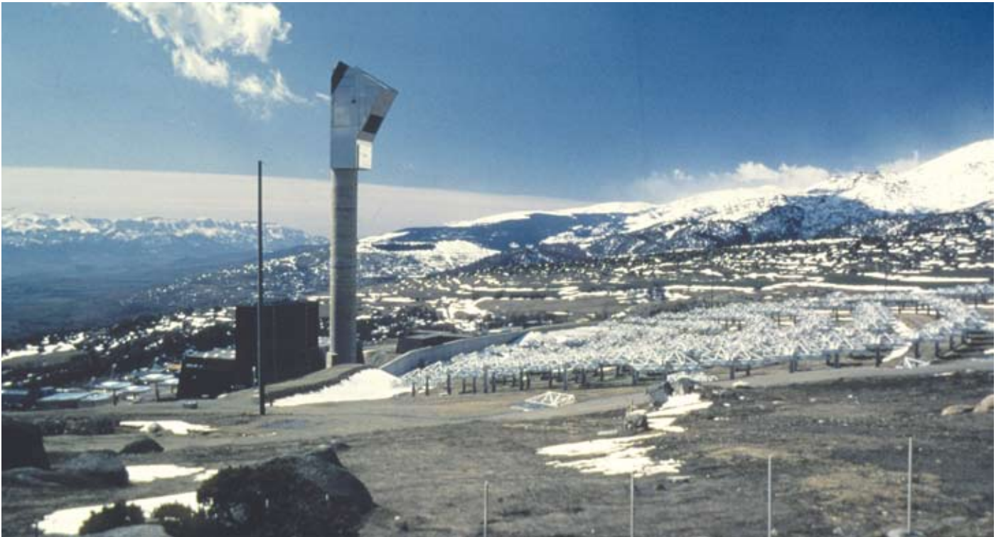
Central de energía solar Themis (Francia).
