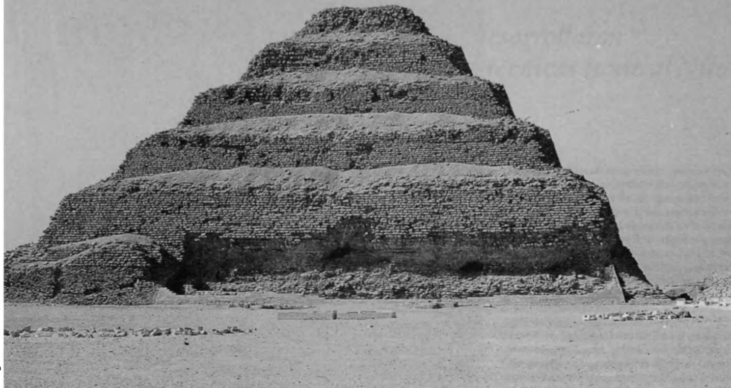
▲ La “residencia de eternidad” del rey Djoser (h. 2630-2611 a.C.) en Sakkara. Se estima que esta pirámide de seis escalones y 60 metros de altura, hecha con materia calcárea blanca, es el primer monumento de piedra de la historia.
