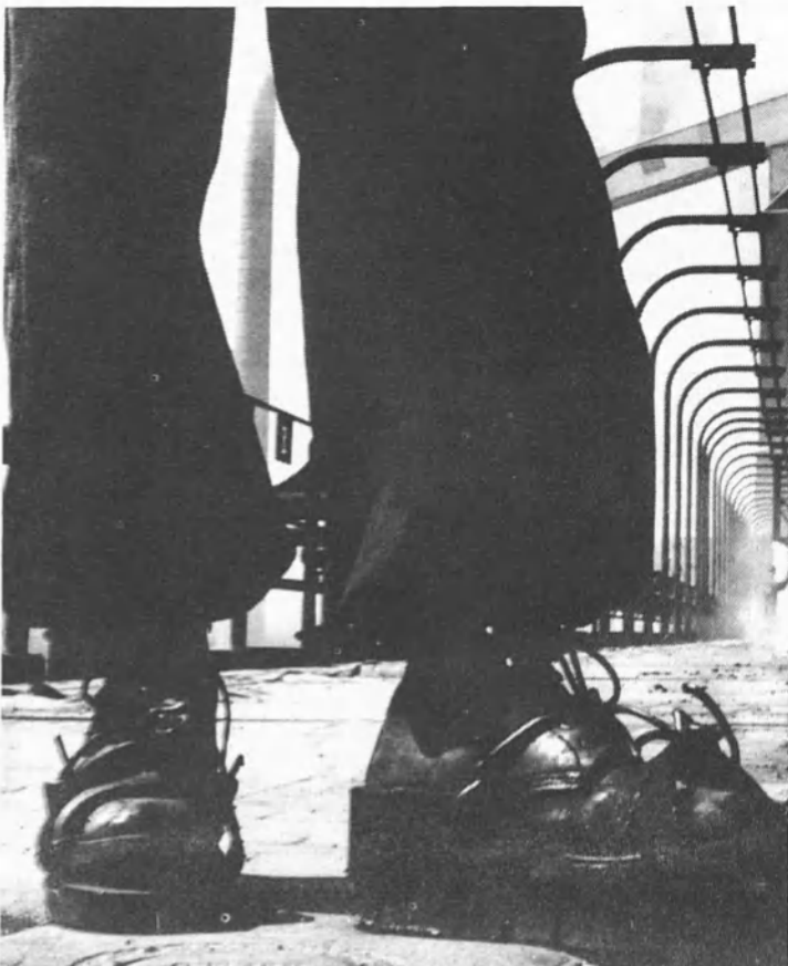
Y PIES Los chanclos de madera o zuecos (abajo, a la izquierda) protegen al obrero de la fundición del intensísimo calor de los hornos que tiene debajo. La cubierta protectora que se calza sobre los zapatos corrientes resulta de una importancia vital en las plantas atómicas, en que los suelos pueden verse contaminados por la radiación.
