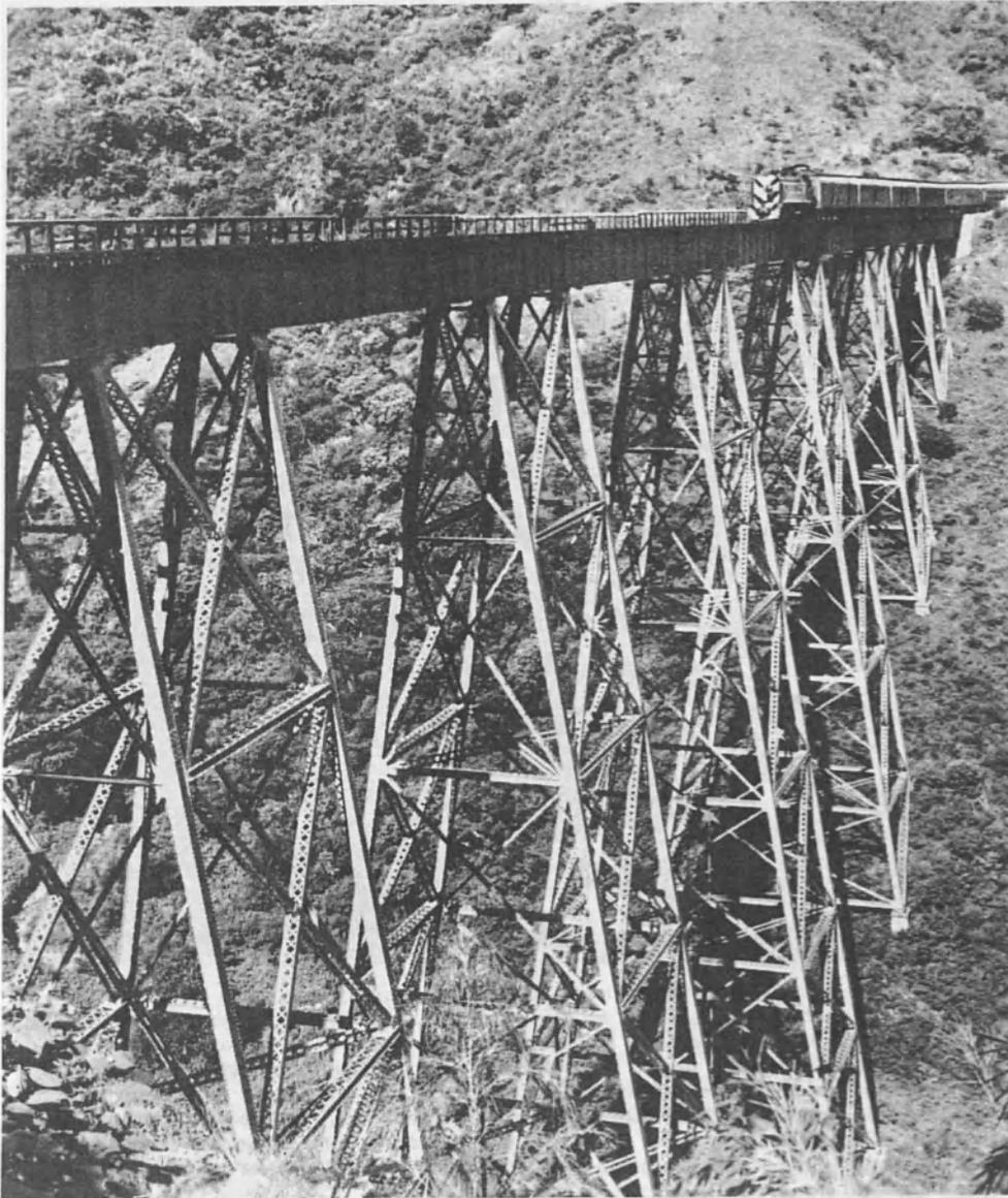
En una sección montañosa cerca de Guadalajara, el Ferrocarril del Pacífico trepa hasta 3.000 pies de altura, en menos de 50 kilómetros, penetra por 25 túneles, en 30 kilómetros, y cruza quebradas de mil pies de profundidad. En terreno semejante, la construcción de la línea fué una de las más difíciles operaciones del mundo. Arriba, una locomotora Diesel ultramoderna pasa sobre un puente recién construido. Abajo, los obreros reforsan el puente de madera y colocan nuevas traviesas.
