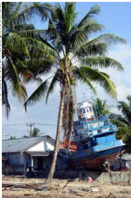
El pueblo de Baan Khem (provincia de Phang Nga, Tailandia), resultó gravemente afectado por el tsunami del 26 de diciembre de 2004.
