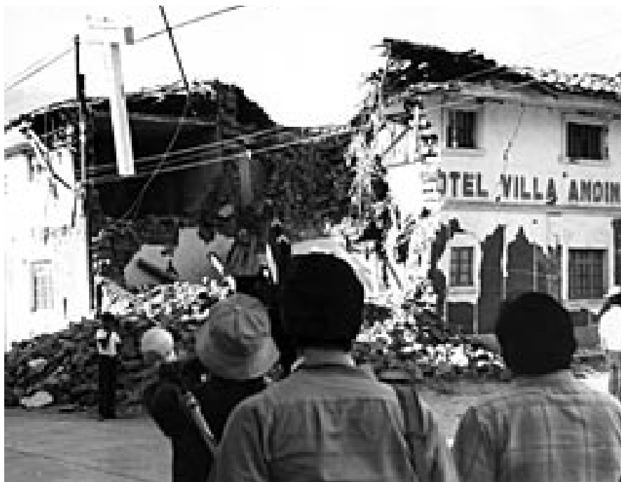
Un equipo del Noticiero rueda el terremoto en Perú (1970). © ICAIC
