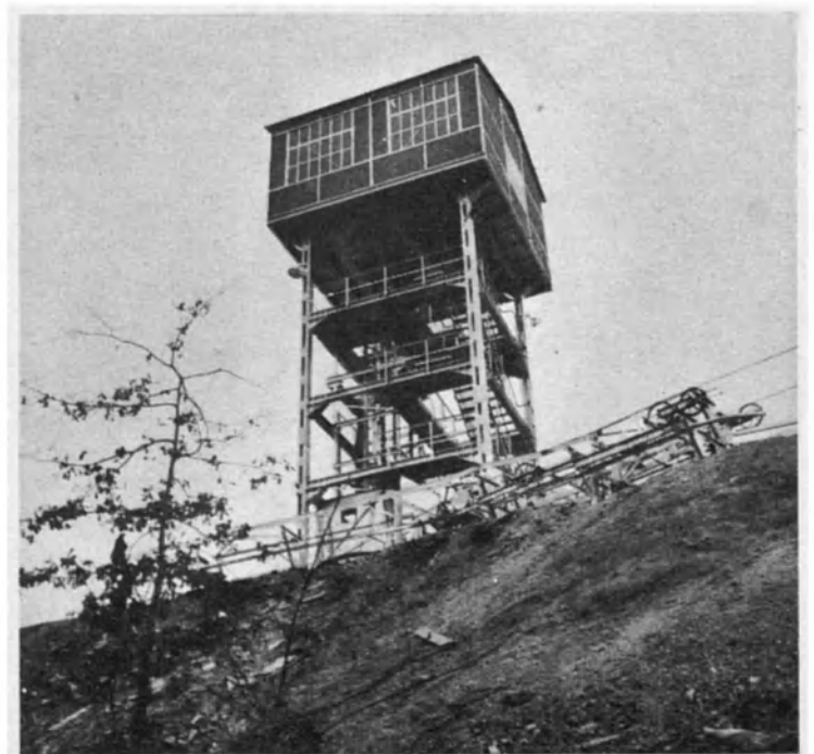
TORRE DE EXTRACCIÓN de minerales y estación de partida del transbordador aéreo, cerca del Estanque de Reliez, en el Puy-de-Dôme, centro de Francia. Este yacimiento está explotado por el Comisariato Francés de Energía Atómica (C.E.A.), organismo cuyo personal se compone de 3.350 personas.
