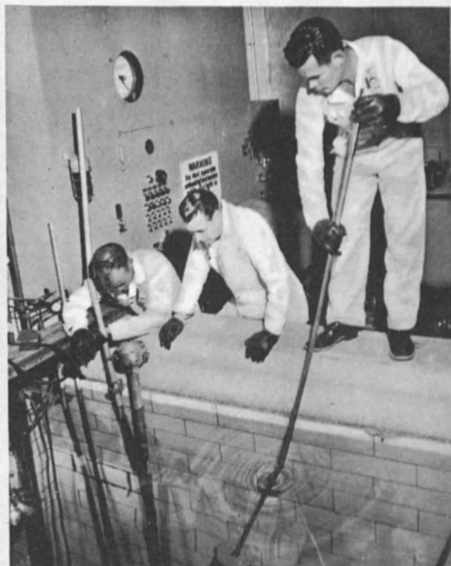
EN UN REACTOR ESPECIAL de un centro de investigación atómica de los Estados Unidos se somete a prueba el material. A la izquierda, se sumergen botes de carne en conserva en el agua del canal que conduce al reactor. La prueba mostrará si los recipientes y el contenido sufren el efecto de las radiaciones. A la derecha, los técnicos utilizan pinza de largos mangos para sacar un tubo de aluminio, lleno de cobalto radioactivo. (Foto USIS).
