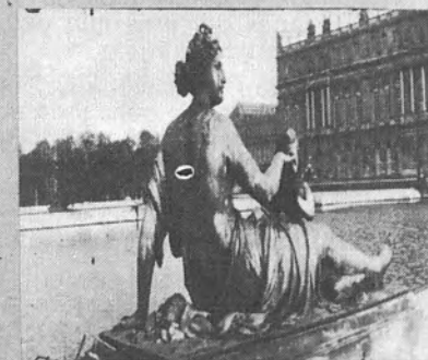
II Vue prise du même point, avec le même appareil ordinaire et le même objectif, mais muni de l'Hypergonar: la vue est anamorphosée dans le sens horizontal, le champ est doublé en largeur.
