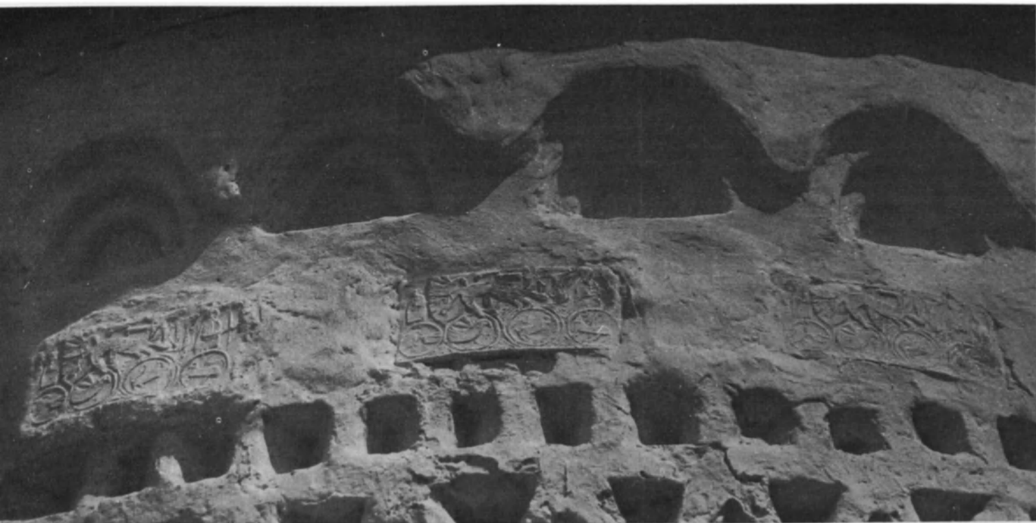
Detalle de la arcatura y de las tejas de cerámica que adornan el tambor en que se apoya la cúpula de la iglesia de San Jorge de la Colina, en Pskov. La construcción data de fines del siglo XV.
