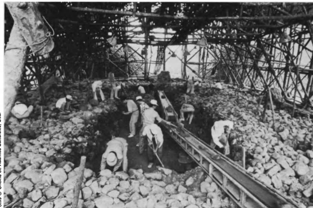
Antes de retirar los guijarros se ha construido un techo para proteger las reliquias.
