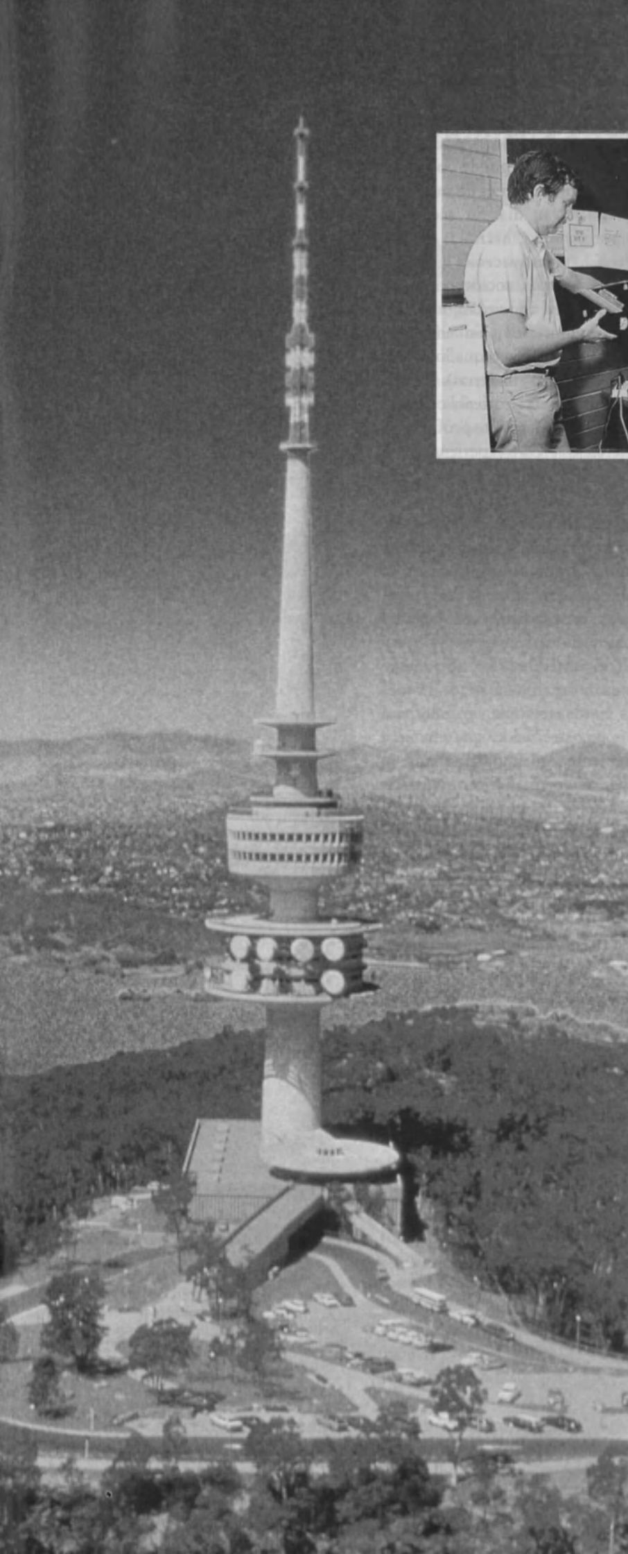
La torre de telecomunicaciones de Black Mountain, a orillas del lago Burley Griffin, Canberra.
