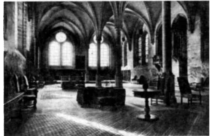
Para volver a ser un centro internacional de reuniones célebres, la antigua abadía cisterciense de Royaumont se ha modernizado. La calefacción central sin embargo no ha hecho perder al edificio su austera belleza gótica, como puede verse por la fotografía que representa el refectorio.
