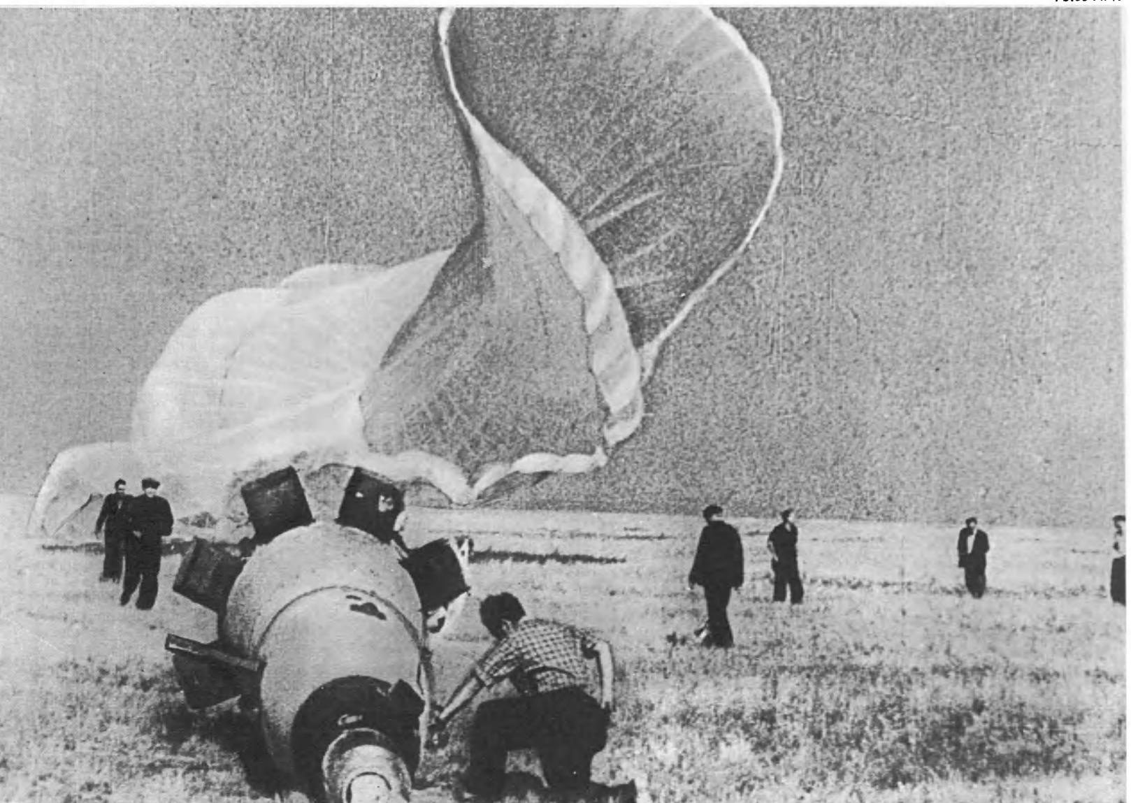
REGRESO DEL ESPACIO. Los técnicos soviéticos recobran las cápsulas lanzadas en paracaídas desde cohetes de estudio luego de volver a penetrar éstas en la atmósfera terrestre. Dichas cápsulas han transportado animales vivos fuera de la tierra, pero gracias a los paracaídas gigantes usados para estas operaciones los animales hacen un aterrizaje suave luego de su vuelo por el espacio estelar.
