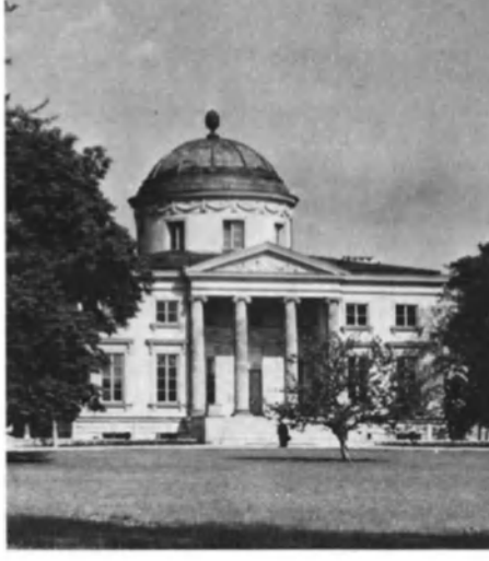
La Villa Krollkarnia, construida en Varsovia (Polonia) por el arquitecto Demerlini en 1786-1789, también de manifiesta inspiración palladiana.
