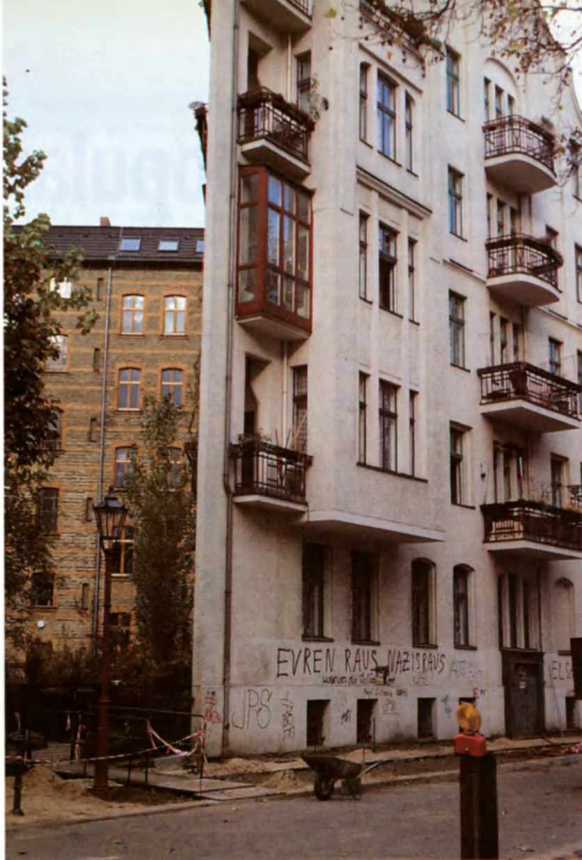
Edificio construido en 1964 en el sector de Landwehrkanal.
