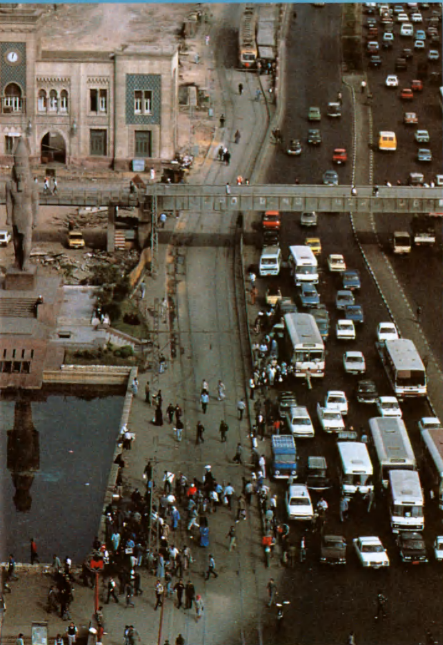
Construcción, terminada actualmente, de una vía para tráfico rápido que atraviesa el centro de El Cairo.
