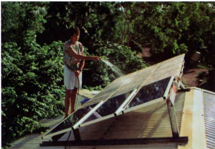
Limpieza de un panel solar en una casa australiana.
