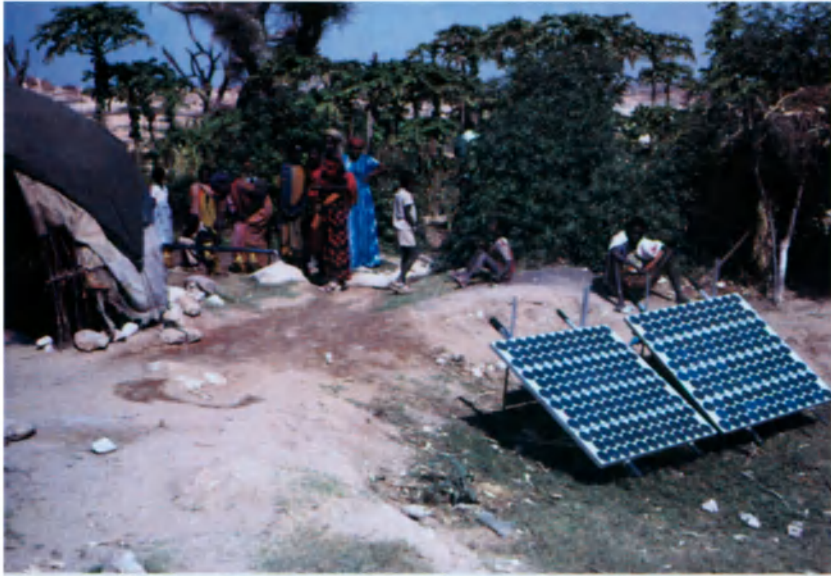
Arriba, bomba de agua accionada con energía solar en un campo de refugiados, Hargeisa (Somalia).
