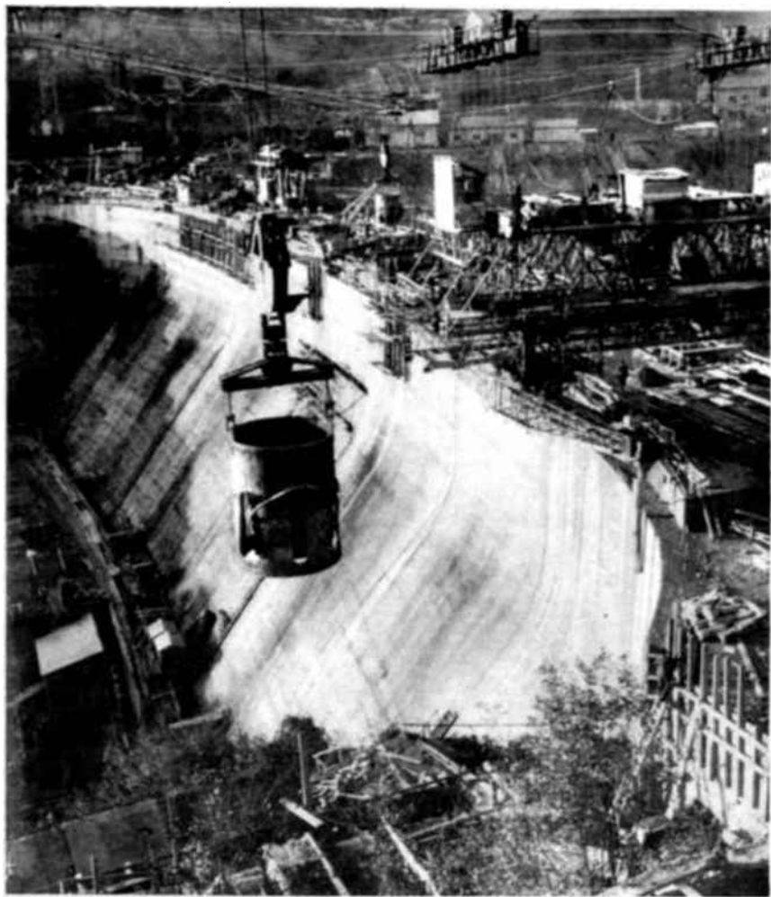
En febrero de 1948 entró en servicio la mayor y más potente presa de Europa: la de Génissiat, en el Ródano (v. arriba). La obra, comenzada en 1936 e interrumpida por la guerra, mide 104 metros de altura, tiene 180 metros de anchura, su espesor en la base es de cerca de 100 metros y representa una cubicación de 650.000 metros cúbicos de cemento. Una vez estén terminadas todas las instalaciones, la producción anual de Génissiat será de dos millones de kilowatios. Las principales presas del mundo en la actualidad son: la de Boulder-Dam (cinco mil millones de kilowatios hora); la de Grande-Coulée (once mil millones), y la de Dneiprostroi (tres mil doscientos millones). Para comprender su importancia social basta recordar la admirable obra realizada por las 20 presas que, en menos de diez años, han transformado el valle árido y devastado de Tennessee en una región rica y próspera, gracias a los trabajos de la T.V.A. (Foto United Press.)
