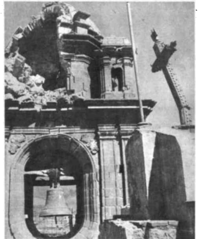
La Iglesia de la Compañía (construida por los Padres Jesuitas), como la de la Merced, la de San Sebastian la Catedral y otras, sufrieron los embates del temblor, y a pesar de la gran solidez de su construcción, que puede apreciarse bien en esta foto, donde vemos la torre derecha de la primera de las mencionadas Iglesias (la de la Compañía), cuya parte superior izquierda queda demolida y cuarteado gravemente todo el resto del edificio. En la parte derecha de la foto aparece el estado en que quedó la gran cruz de piedra labrada de la fachada principal de la iglesia.
