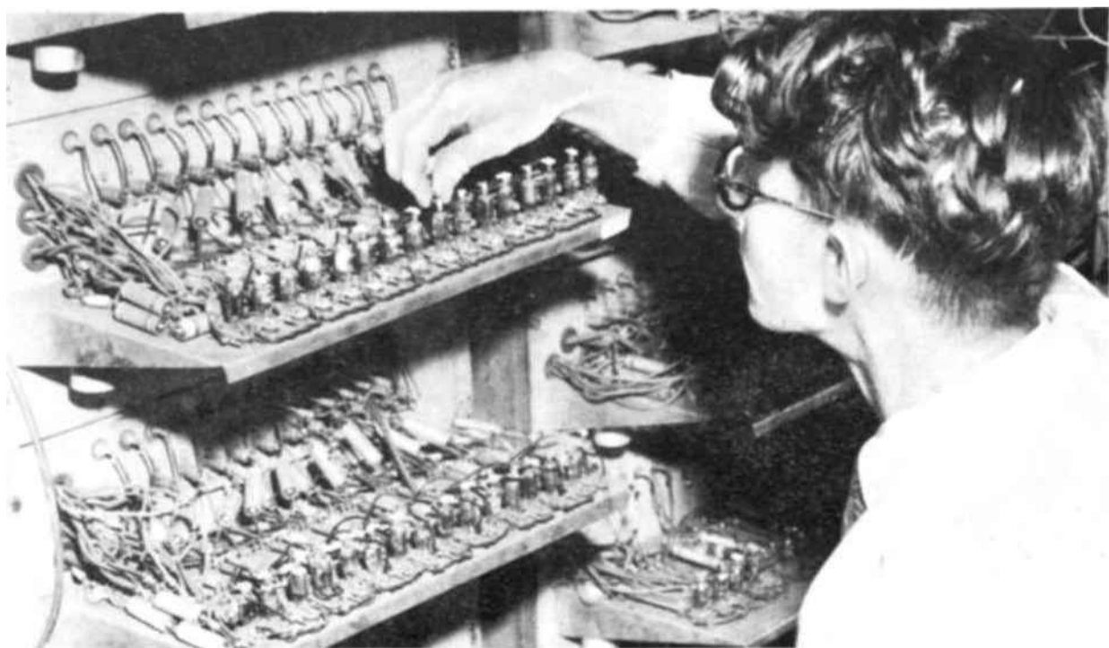
DETECCION ELECTRONICA: con más de 12.000 tubos electrónicos que contienen las actuales máquinas calculadoras, ciertas averías son inevitables. A causa de ello, los ingenieros deben mantenerse en servicio continuo, listos para localizar en seguida los tubos o conexiones estropeadas. (Foto I.N.P.)
