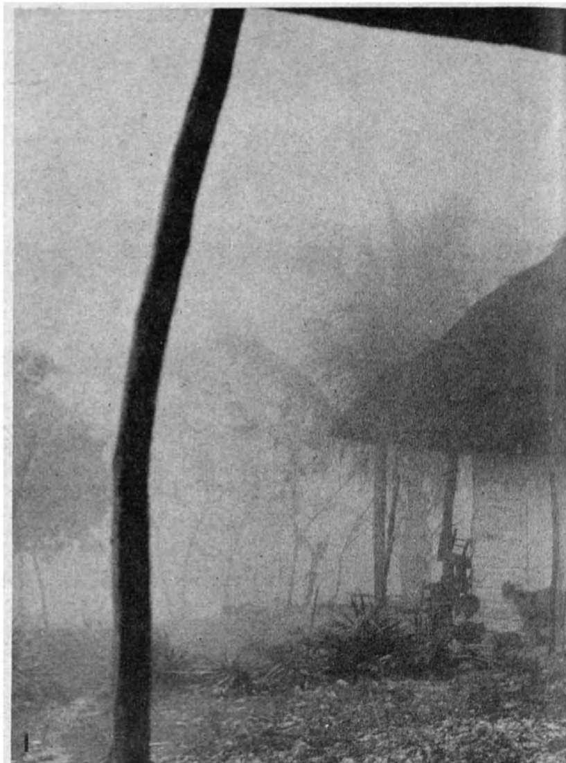
Una casa rural típica de Haití. Consiste únicamente El piso es de tierra
