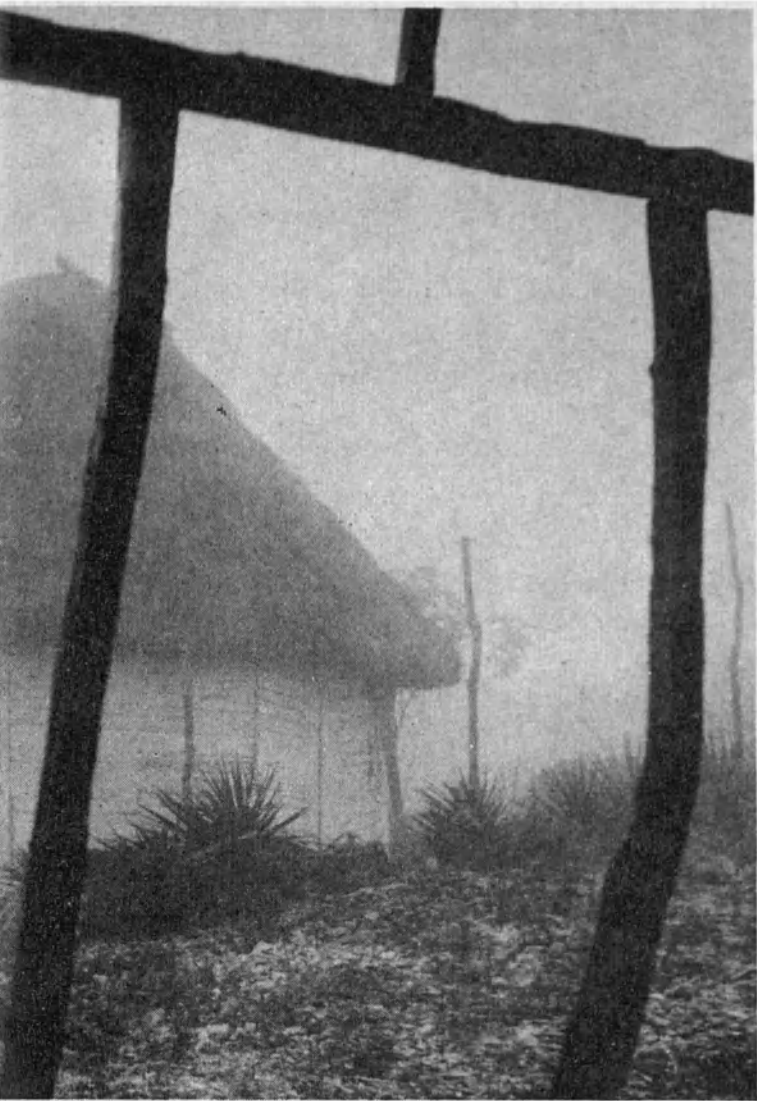
en una sola habitación cuya armazón es de madera, y techo de paja.
