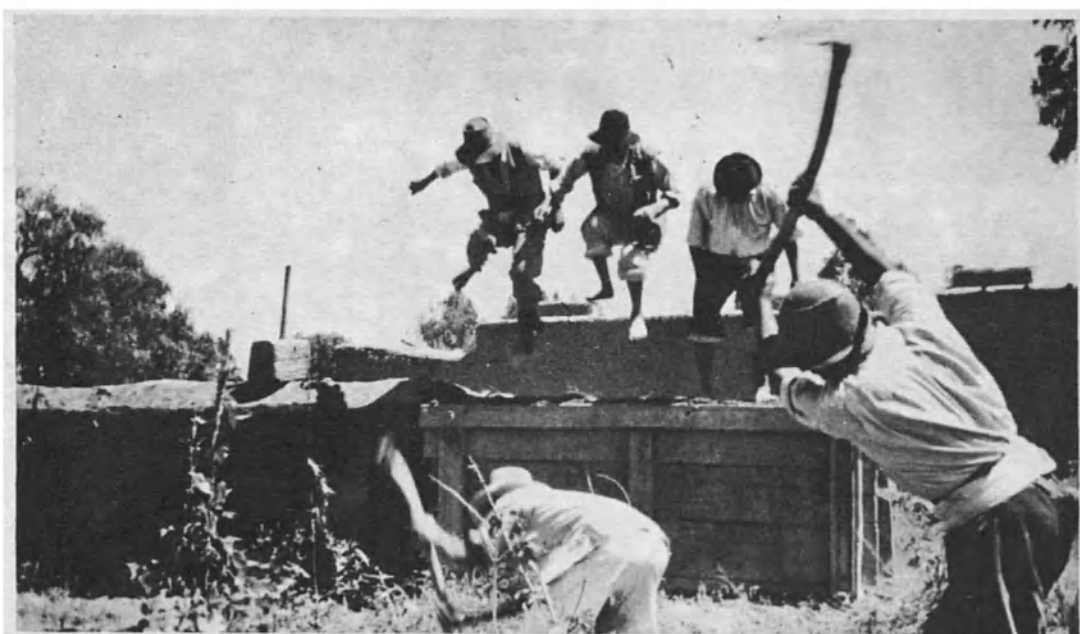
Como en tiempos del Imperio del Sol, los muros son de tierra apisonada. Para que la tierra se vuelva resistente a las inclemencias del tiempo, es menester comprimirla y volverla compacta. Con este fin se la aplasta con los pies, en un movimiento rítmico de danza. (Foto I.L.O.)
