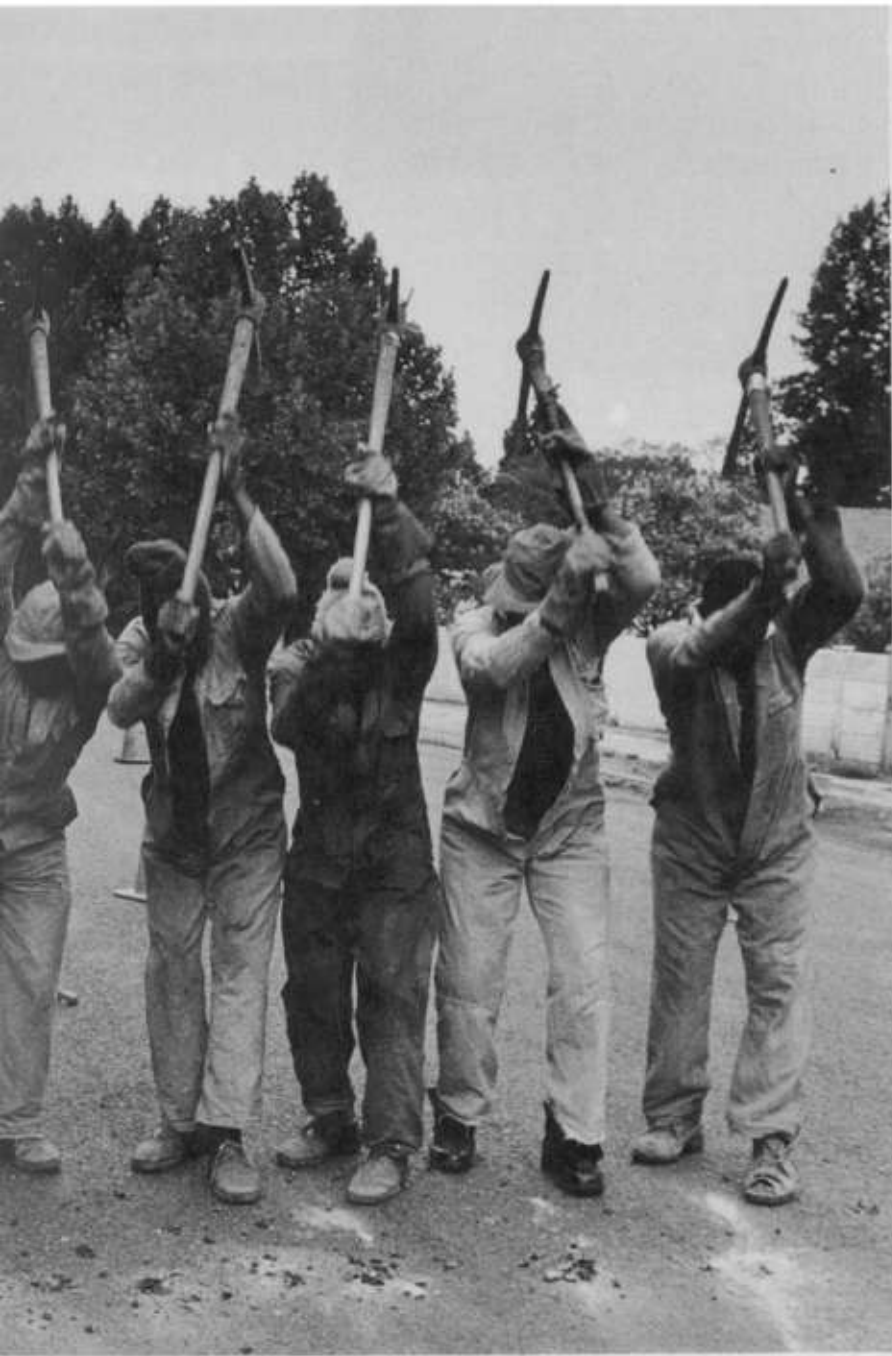
Obreros sudafricanos trabajando en una carretera.
