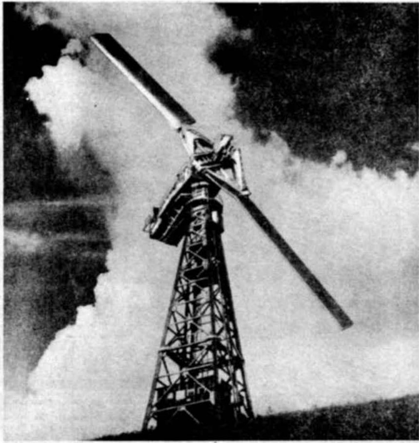
El mayor generador eólico construido hasta la fecha es el que podemos ver en esta fotografía, erigido en Vermont Hill, Estados Unidos. Su hélice alcanza un diámetro de 53 metros.
