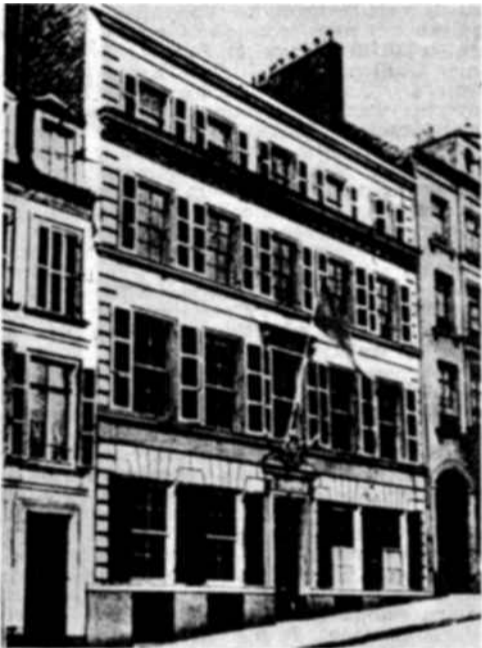
Fachada del inmueble número 105 de la Grand'Rue de Boulogne-sur-Mer, en cuyo piso alto (1º) falleció San Martín el 17 de Agosto de 1850.
