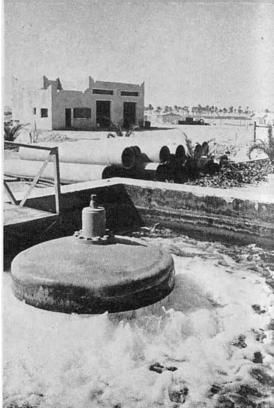
Pozo artesiano de Uargla, en el Sahara. Aquí el agua se oculta bajo el lecho del desierto. El agua artesiana se ve alcanzada a profundidades variables en las perforaciones: 75 metros en El Golea, 1.000 ms. en Uargla, 1.500 ms. en Tugurt. La reserva de agua de la inmensa cuenca artesiana del Sahara se calcula en 12 billones de metros cúbicos.
