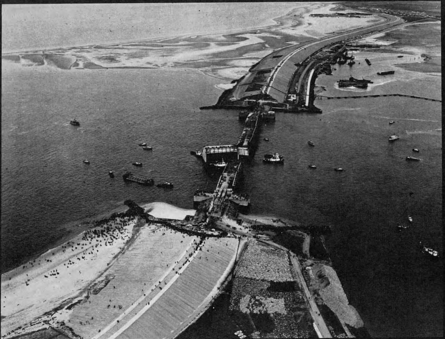
Foto © Mastboom Vliegbedrijf-Hofmeester
